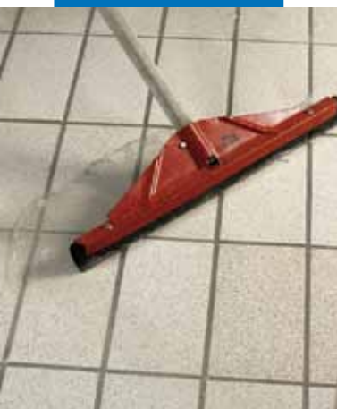
Eliminación de residuos líquidos con rastrillo de goma
