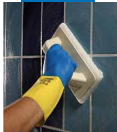
Kerapoxy CQ se emulsiona con agua, utilizando una esponja Scotch-Brite®
